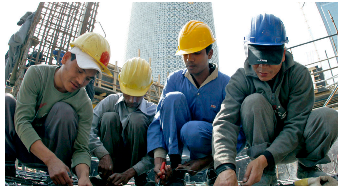
Trabajadores migrantes ensamblando barras de metal en una obra de construcción en Qatar. © Imagen OIT/Apex
