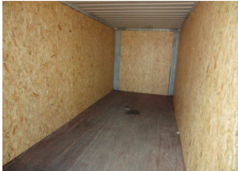
Figure 7.53 – Revêtement d'un conteneur de 40 pieds (12 m) à l'aide de panneaux en bois aggloméré
