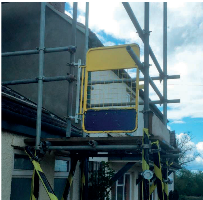
Slika 13. Samozatvarajuća vratanca na ulazu u skelu.
