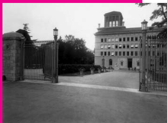
ILOのために特別に建造された最初の事務局建物はローザンヌ（スイス）のジョージ・エピトーによって設計された。ジュネーブのローザンヌ通りに位置し、1926年から1974年まで使用された。後にGATT（関税貿易一般協定）及びWTO（世界貿易機関）の本部となった。（今日のアルベール・トーマ広場からの眺め）
