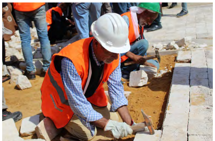
Construction d'une route sur la commune de Takelsa.
