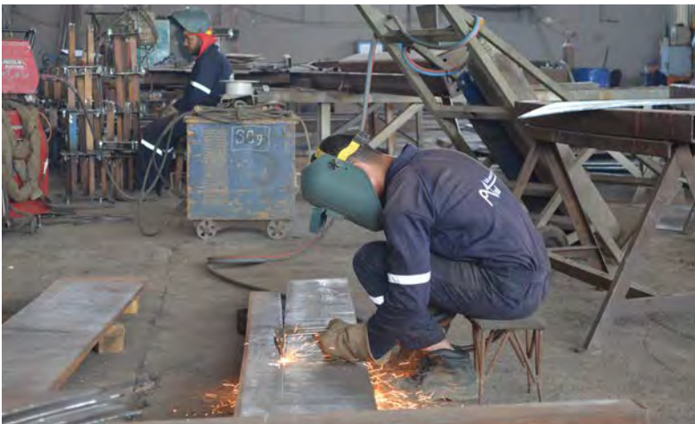
Un travailleur portant un équipement de protection.
