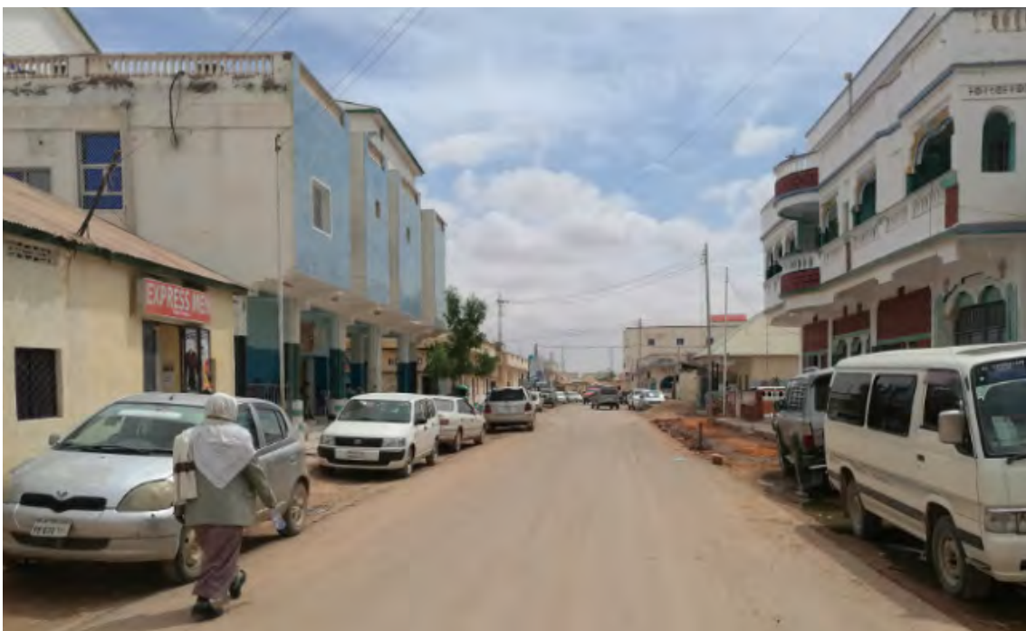
La route vers le stade d'Awale, à Gaalkacyo, une fois terminée.
