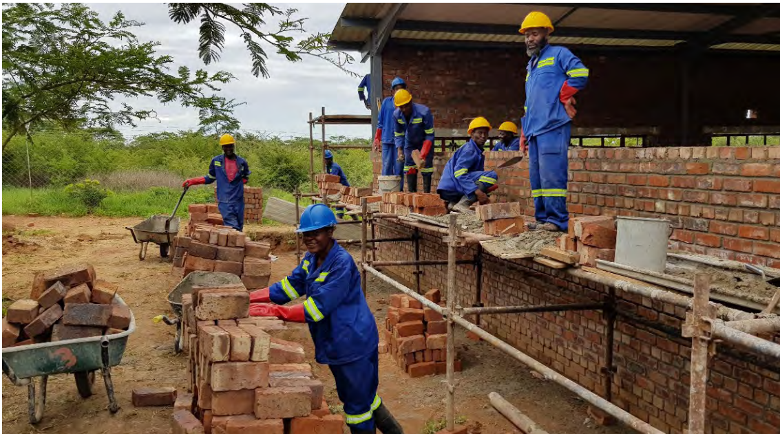
Travaux de construction dans une usine de production de concentré de tomates à Mutoko, Zimbabwe.
