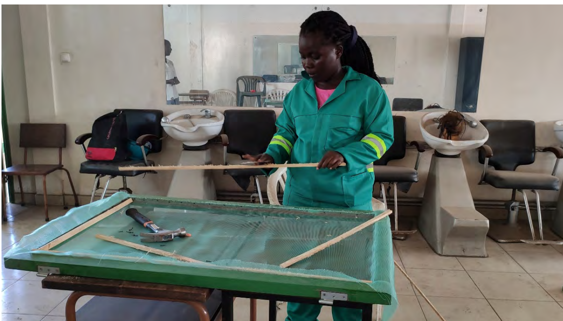
Manuela pose un nouveau cadre sur une fenêtre avec une moustiquaire.
