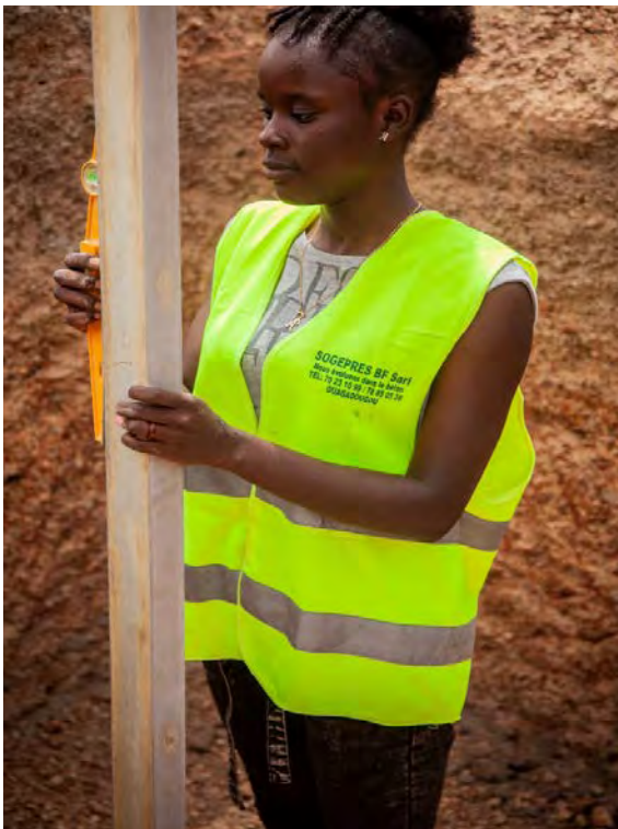
Apprentie maçonne sur un chantier.
